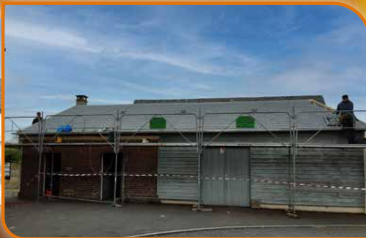
Rénovation toiture du bâtiment technique
