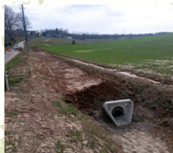
Travaux route de la Vallée
